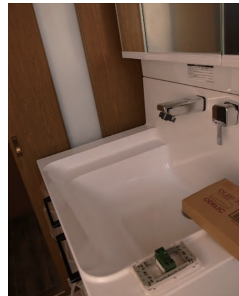
洗面台 | 設備交換
