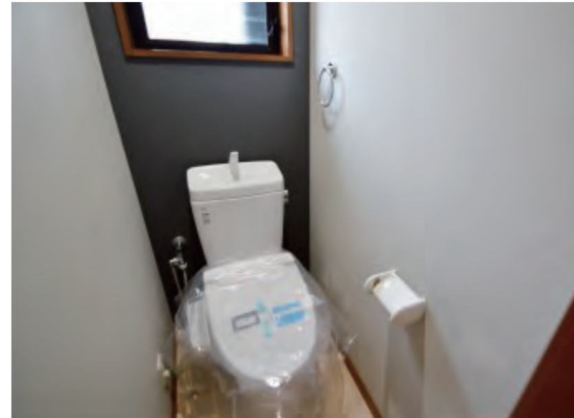
トイレ | 設備交換
