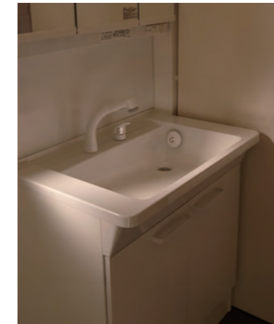
洗面台 | 設備取り替え
