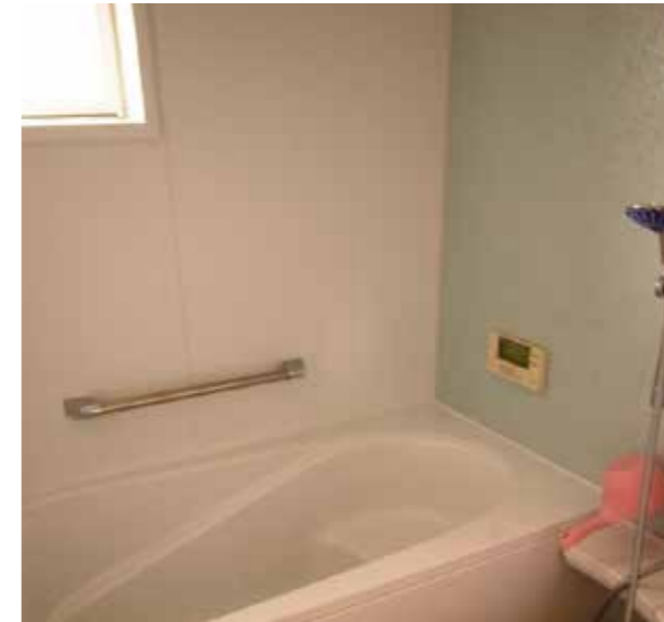
風呂場 | 設備取り替え
