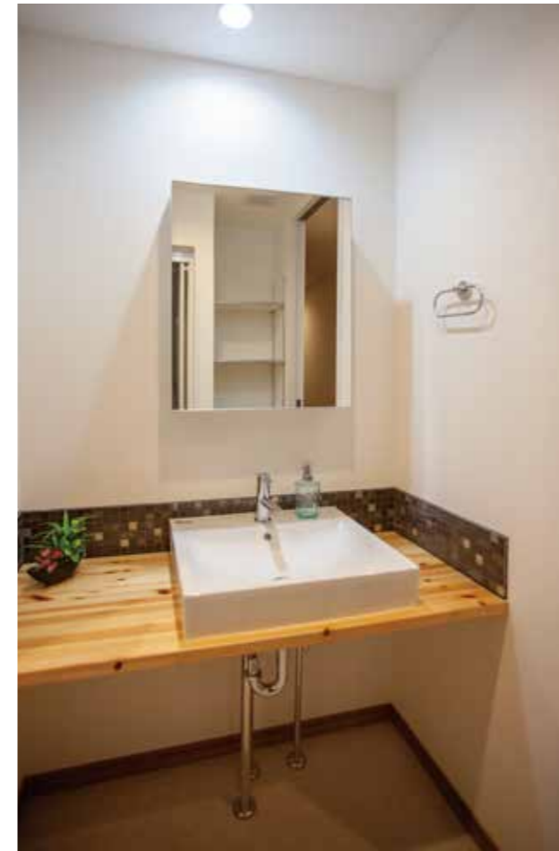
洗面 | 設備交換
