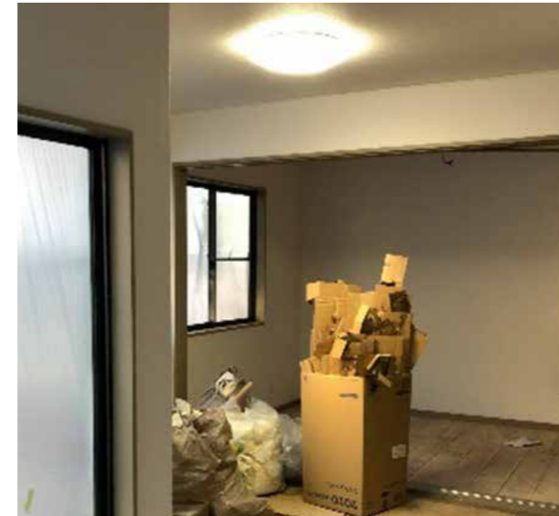
建物内装 | クロス全面張替
