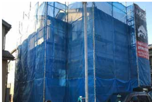
64 屋根、外壁 | 塗装
