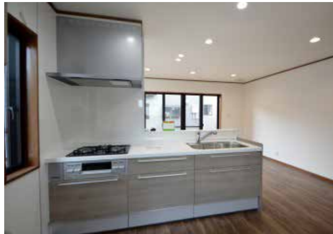
56 キッチン | 設備交換・床張替え
