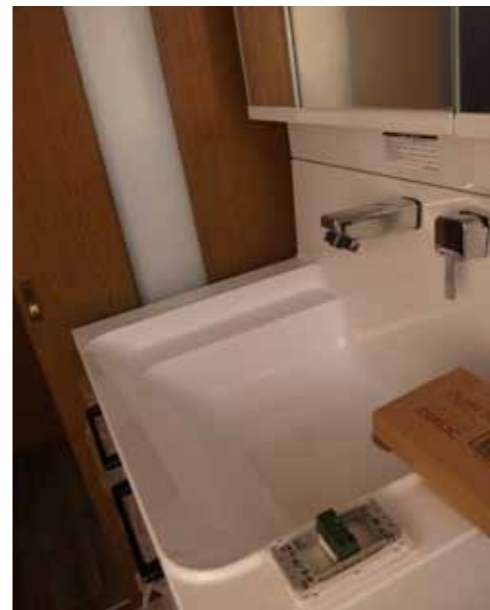
洗面台 | 設備交換
