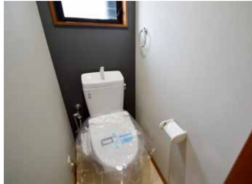
トイレ | 設備交換
