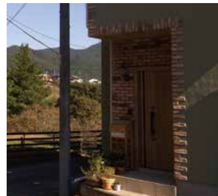
玄関扉 | 交換 外壁 | 塗装
