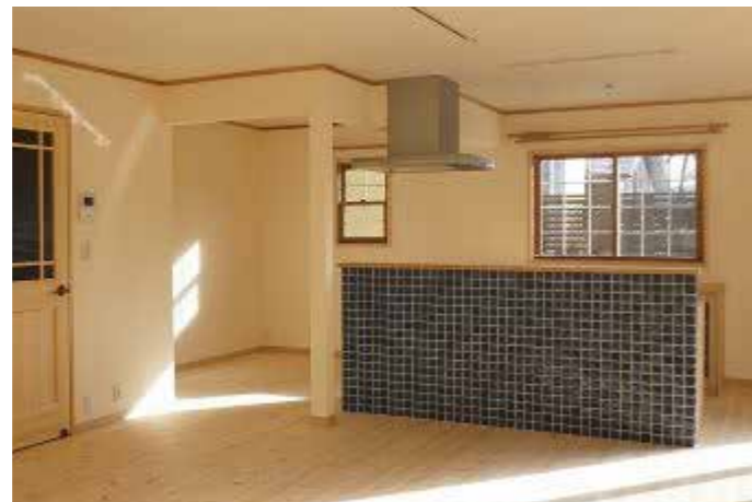
44 リビング | 漆喰塗り・床張り替え・二重サッシ交換
