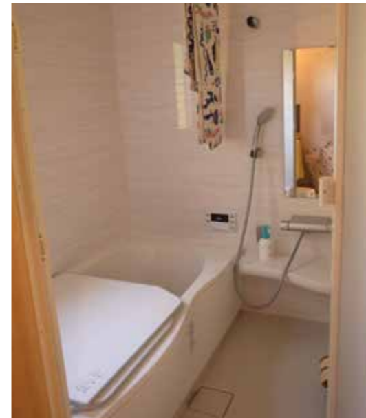
風呂場 | 設備取り替え
