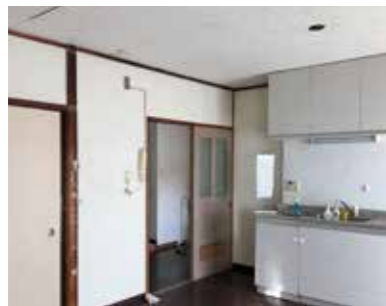
キッチン | 施工前
