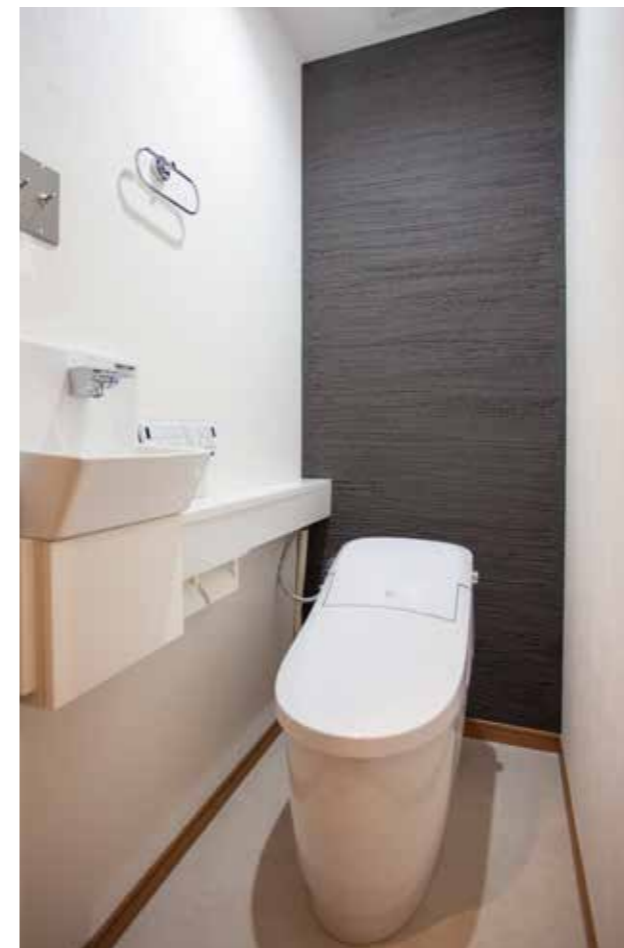
トイレ | 設備交換
