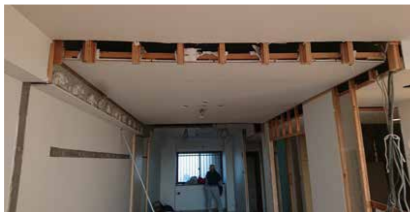
46 施工中[リビングから北洋室]
