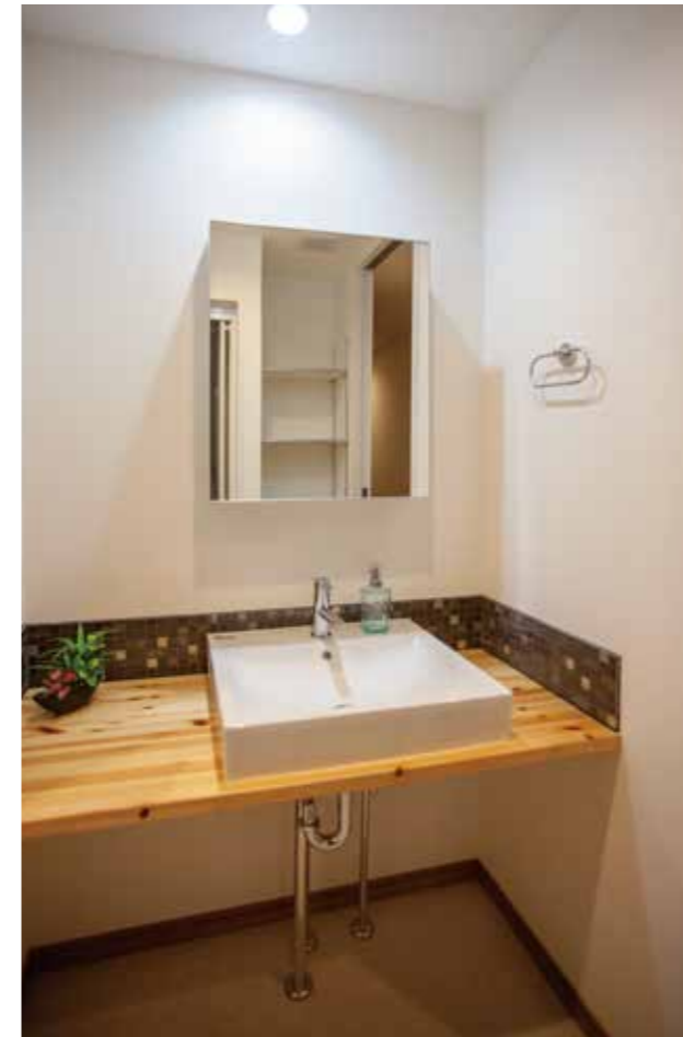
洗面 | 設備交換
