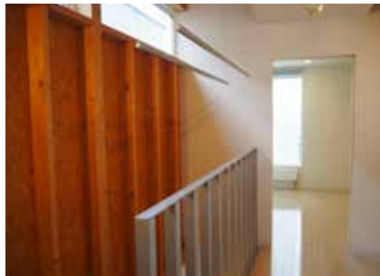
2階廊下 | クロス張り替え
