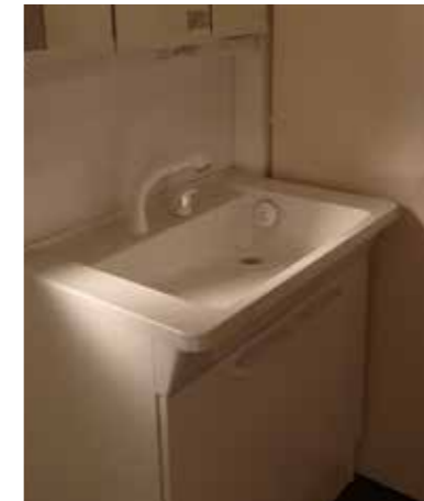
洗面台 | 設備取り替え
