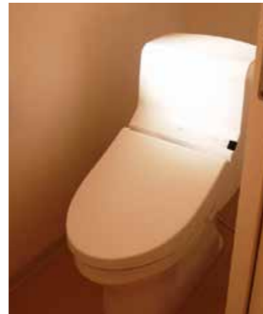
トイレ | 設備取り替え
