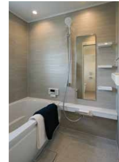
風呂場 | 設備取り替え
