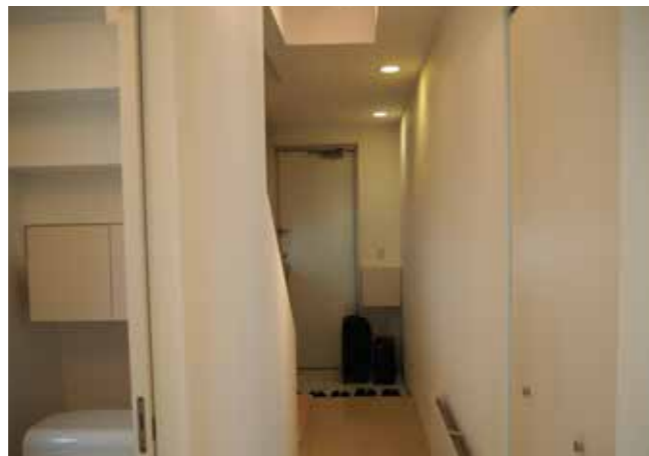
12 玄関・廊下 | クロス張り替え
