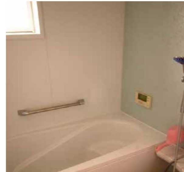
風呂場 | 設備取り替え
